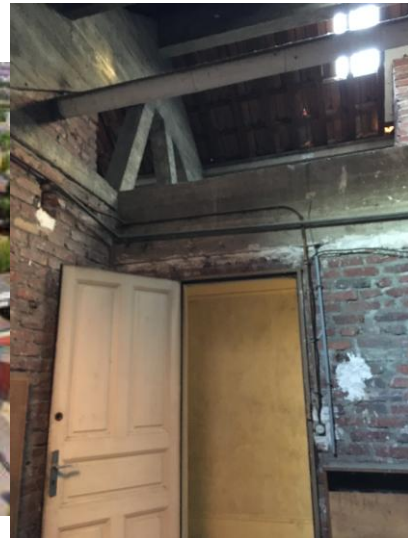
Photo 10 : Combles – charpente béton
